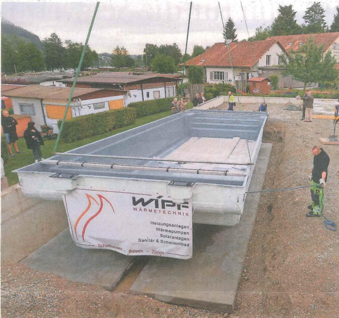
Ausgefüllte Logistik sorgte dafür, dass beim Abladen und Einsetzen des 12,5 mal 5 Meter grossen Poolbeckens aus glasfaserverstärktem Kunststoff alles bestens klappte. Nach einer Stunde stand es in der Betonwand.
